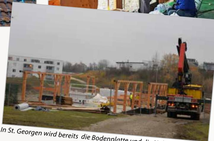
In St. Georgen wird bereits die Bodenplatte und die Holzkonstruktion aufgebaut
