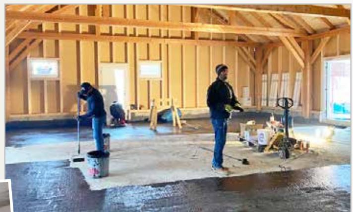
Das Kaltdach ist drauf, die Außenwände stehen, Fenster und Türen sind eingebaut, Sockel ist gestrichen, der Boden erhält einen Bitumenanstrich.
